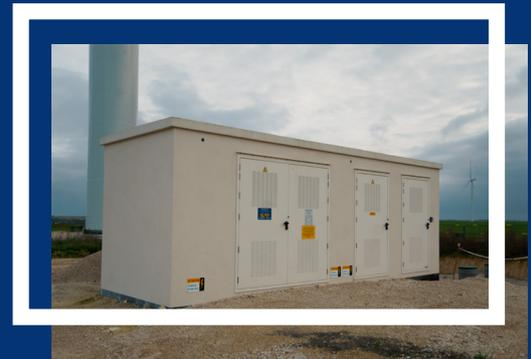
**Poste de livraison** : nœud de raccordement de toutes les éoliennes avant que l'électricité ne soit acheminée via un seul câble vers le poste source de Vertus pour être injectée sur le réseau public.
